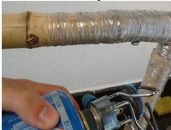
Figura 14 – Procedimento final de uma camada de união das peças metálicas e o bambu do quadro
