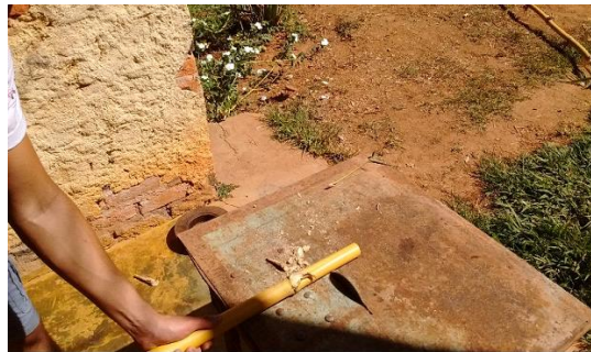
Figura 6 – Limpeza e divisão para transporte dos bambus
